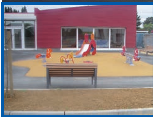
Réfection de la cour de la Maison de l'Enfance
