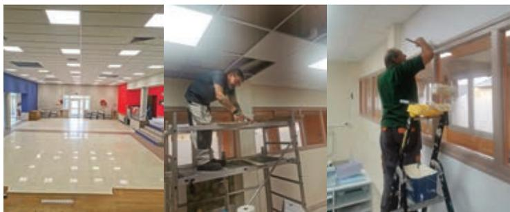
En plus des travaux effectués dans les écoles cet été, les services techniques municipaux ont remplacé les néons de la salle des fêtes par des dalles LED.
